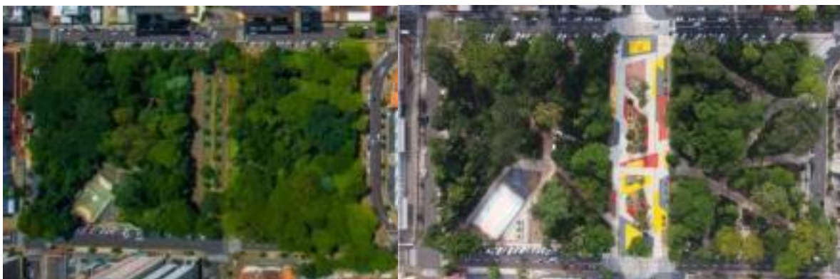
Figura 1. Vista aérea da área do Bosque Marechal Candido Rondon, antes da revitalização (a) e após revitalização (b). Fonte: Carvalho et al. (2022); (a) Vieira (2016); (b) Gaion (2022).
