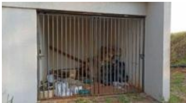
Figura 7. Abrigo externo dos resíduos classe A, B e E.
