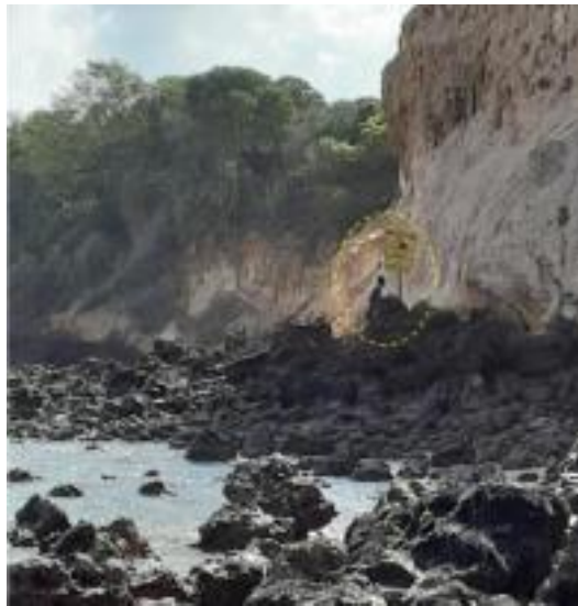
Figura 5. Banhista e turista em locais de perigo de desmoronamento de taludes.
